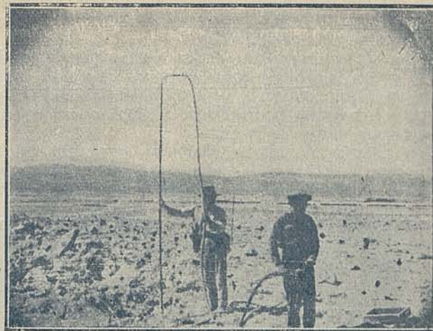
La sopladora utilizando aire comprimido, limpia los hoyos de los residuos dejados por la perforadora.
