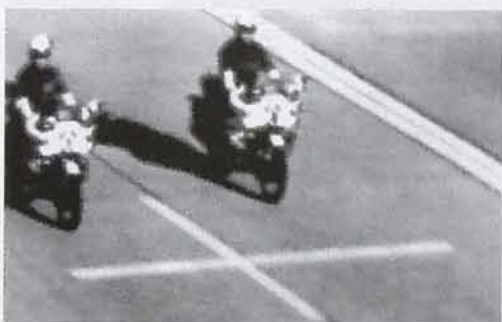
Intervención a las líneas divisorias de las pistas de circulación de una avenida de la ciudad
