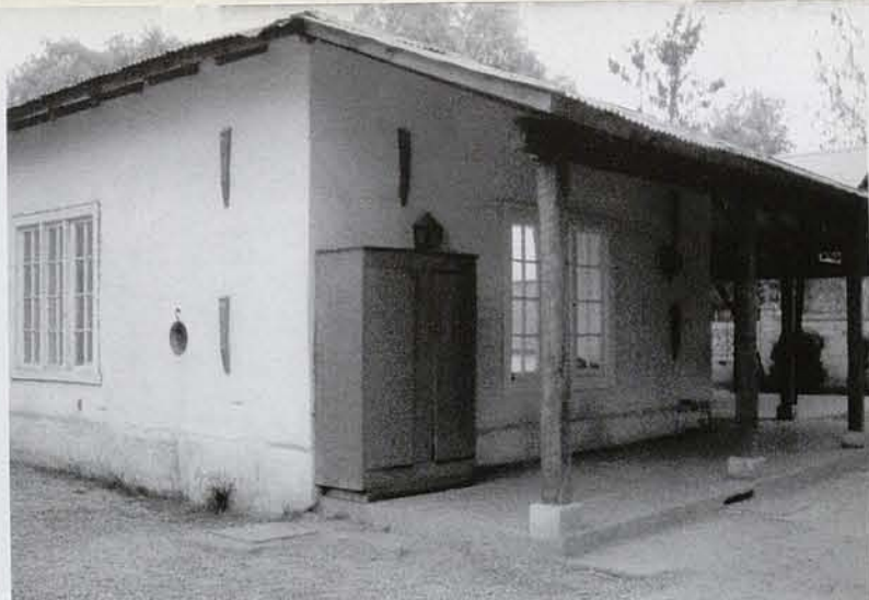
Escuela de lo Arcaya, Pirque; muro de adobe de 60 cm de espesor.
