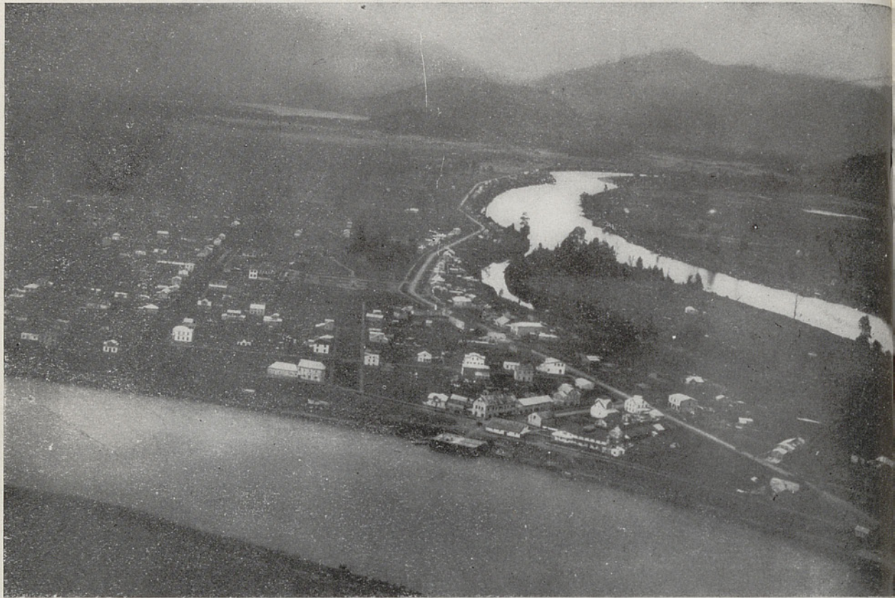
PUERTO AYSÉN, vista aérea .— Foto de la F.A.N.
