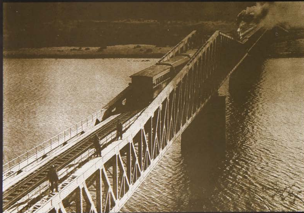
Vista aérea del Puente Banco de Arena.
