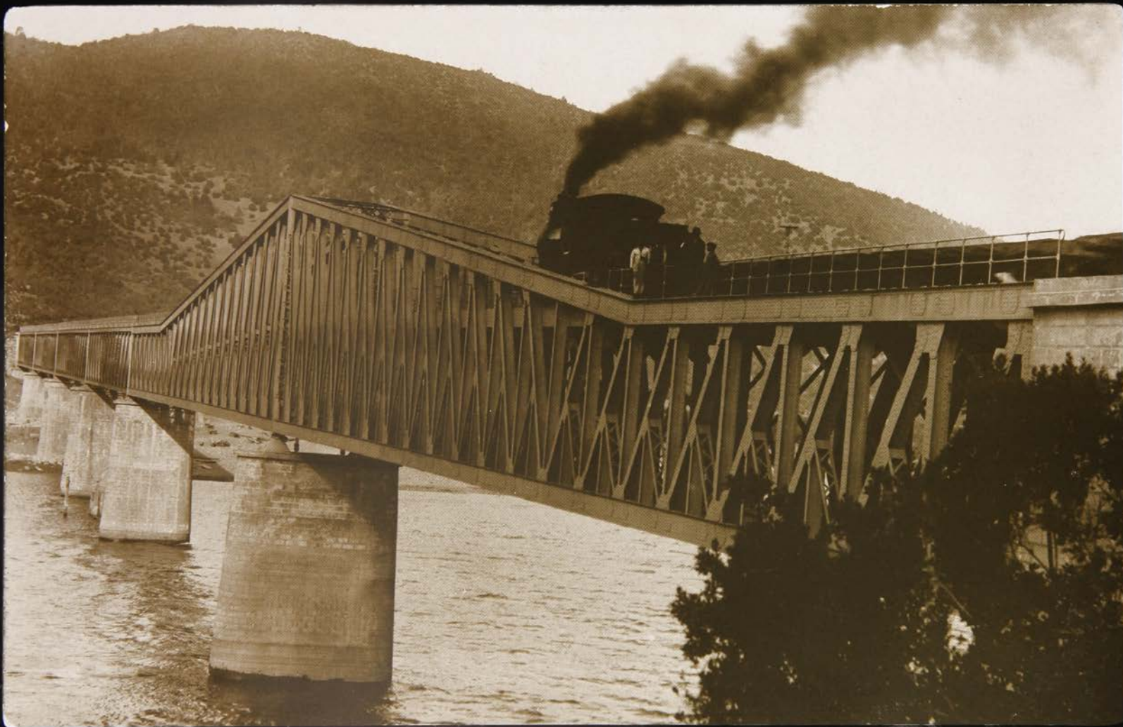
Vista de locomotora sobre el Puente Banto de Arena.
