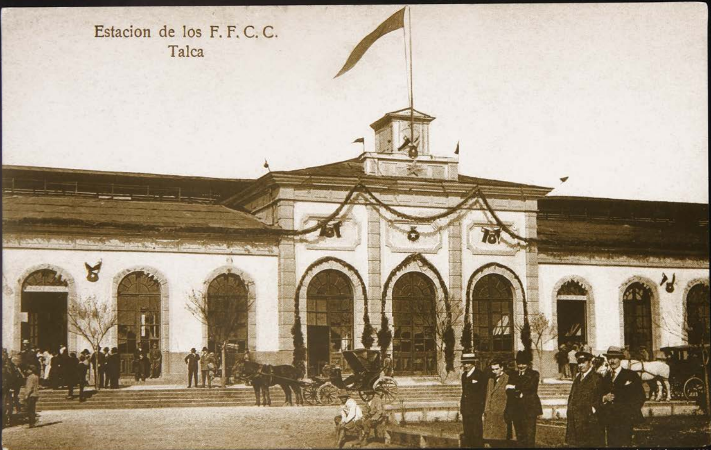
Estación de Ferrocarriles de Talca, año 1931.
