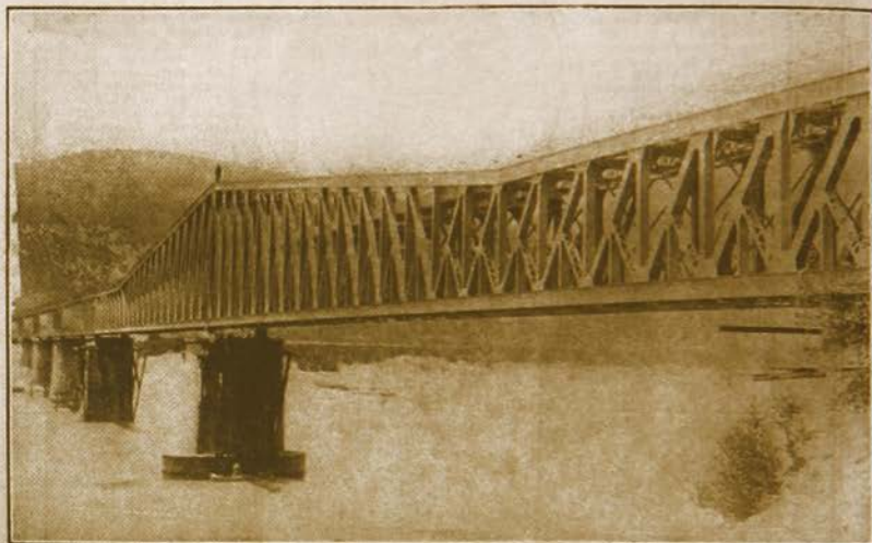
El puente, de 372 metros, construido por el Creusot, con fundaciones en el agua a más de 17 metros de profundidad y cuyo costo fué de £ 65,890.
