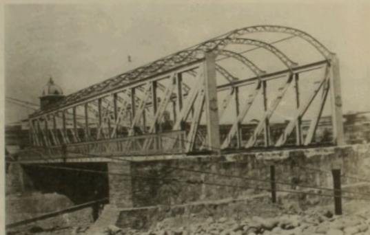
El montaje de los primeros puentes construidos por Lever, Murphy & Co.
