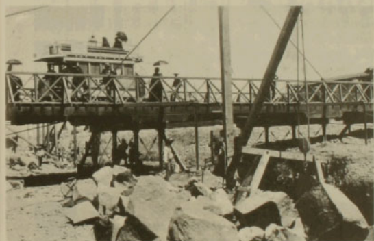
El puente provisional de Vicente Martínez permite unir nuevamente mediante tranvías de sangre La Chimba y el centro de Santiago.
