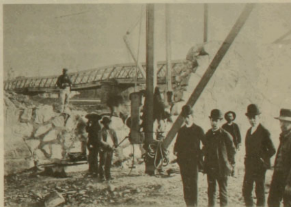
Una visita de obra, mientras se levantan los muros.
