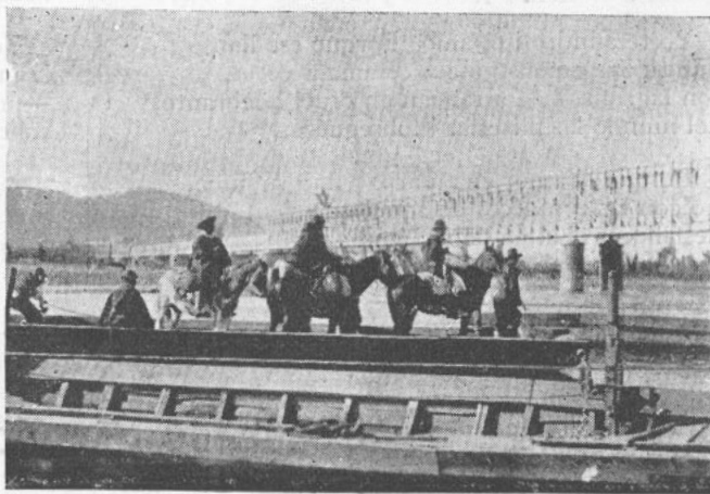
Temuco.—Puente sobre el Rio Cautin
