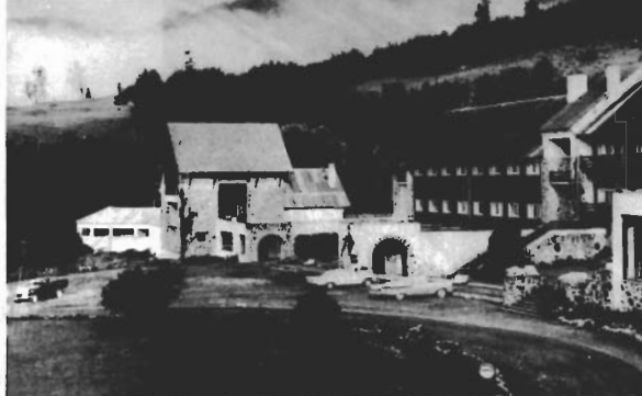
Arriba: Aparece el edificio de las Termas, festonado por compactos pinos y cendales de bruma
