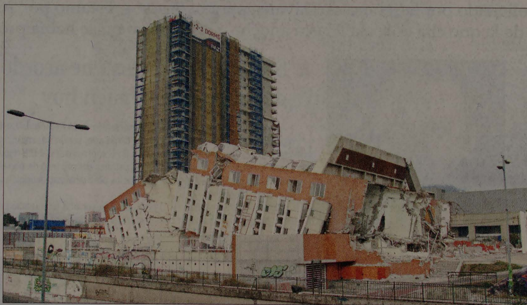
Escasos vestigios. Poco es lo que hoy queda del edificio cuyo colapso (foto superior) impactó al país en 2010.
