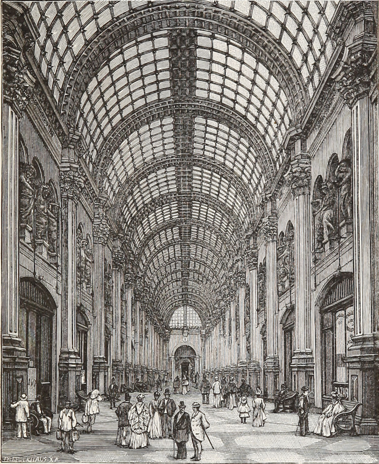
LE PASSAGE SAN CARLOS. SANTIAGO.
