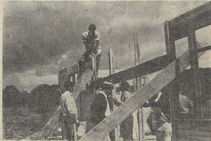
Estudiantes que construyeron una posta en Chacao discuten sobre la ubicación de maderamen de ésta, que se observa bastante adelantada.
