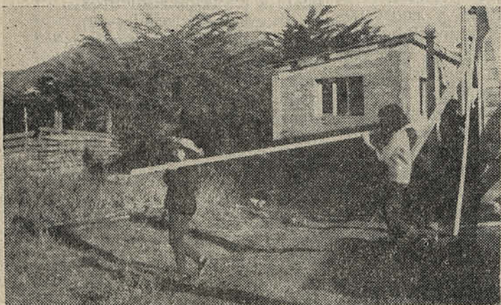
Muchachas cargan un pesado tablón que se utilizará en la construcción de una policlínica.
