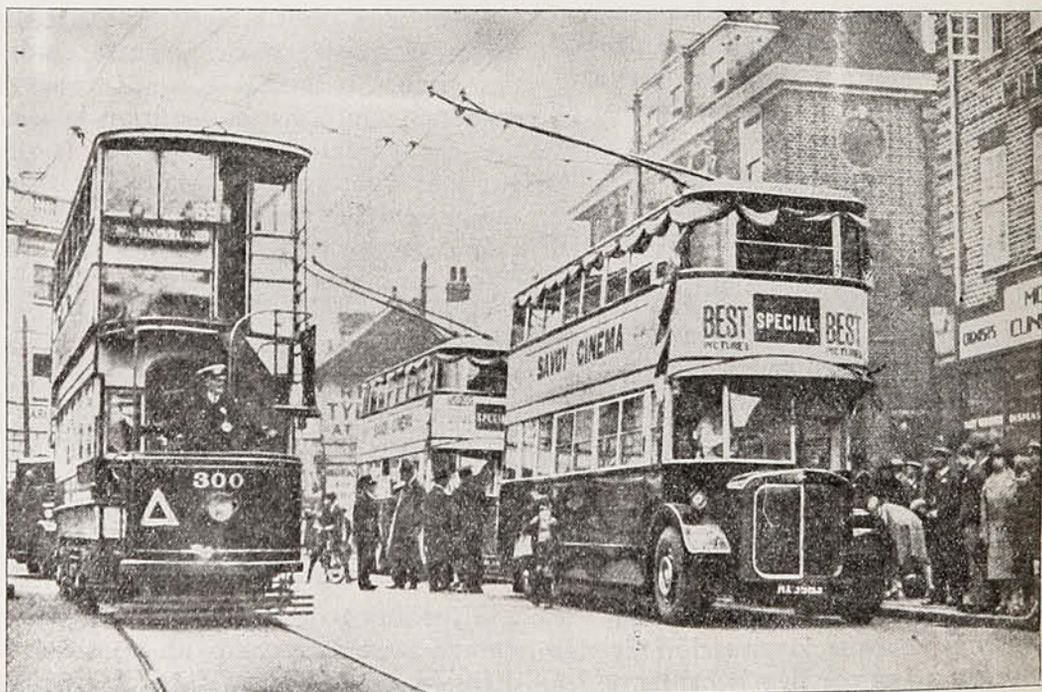
Modelos de trolleybus, en uso actualmente en Londres. Un imperial cerrado de invierno al lado de un tranvía imperial, de los que la empresa ha decidido retirar de la circulación. El trolley tiene dos brazos, uno para recibir, y el otro para devolver la corriente.
