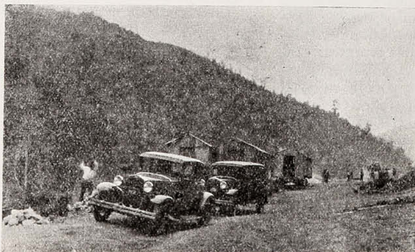
Construcción del camino de Cauquenes a Chanco. En estas el constructor ha empleado únicamente camiones y automóviles Ford y tractores Fordson.
