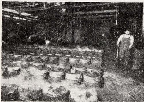
La investigación no se concreta a probetas y retortas; exige también el estudio de métodos de fabricación. El material derretido es vertido en piezas para estudios especiales de resistencia.
