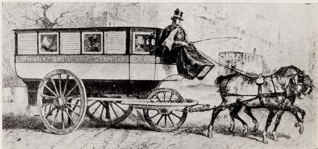
Omnibus Parisien de 1848. Tricillo. Como se observará la suspensión del coche era nula y las tres ruedas no permitían evitar los pozos del camino.
