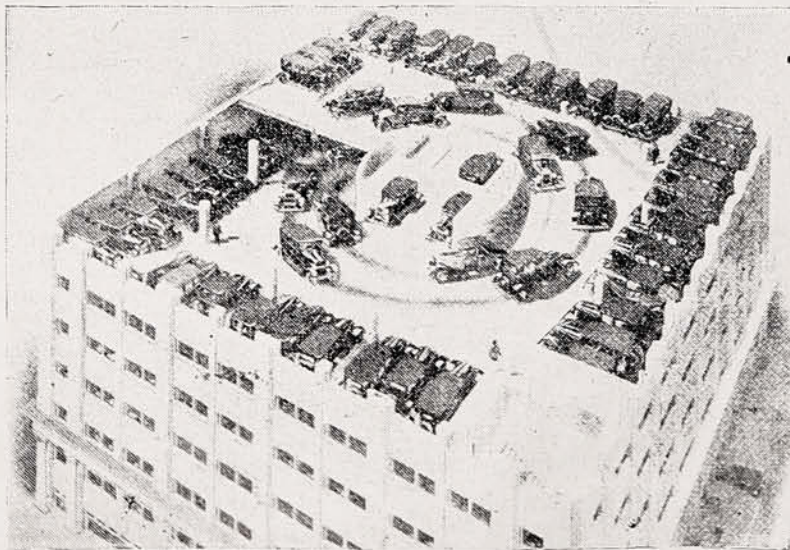
Garage en espiral con capacidad para 400 automóviles. Se calcula que mediante el sistema de rampa puede desalojarse en 17 minutos, cosa que no sería posible con el uso de ascensores.
