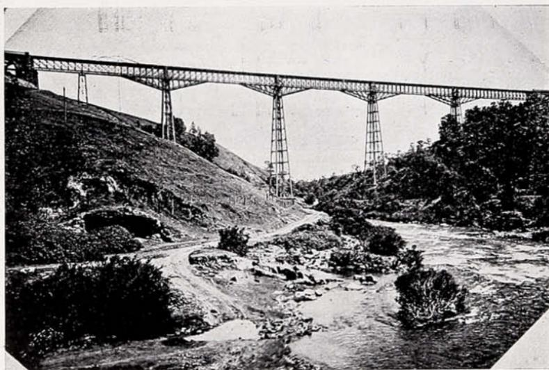
Viaducto sobre el río Malleco, construído en 1890 y que en la época de su construcción fué una de las obras de ingeniería más atrevidas. Su altura es de 102 metros.
