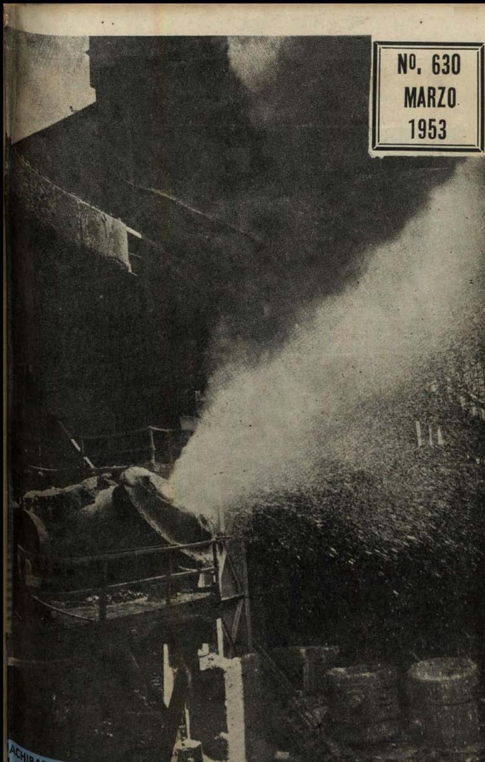
LACHIPATO: El convertidor Bessemer, en la faena de soplado destinada a
