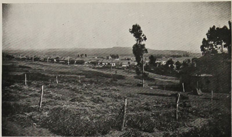
Vista panorámica de la Población Obrera de la Administración del Puerto en Barrancas.
