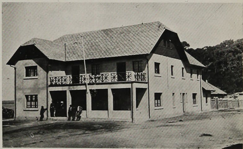
Edificio de la Gobernación Marítima de San Antonio.
