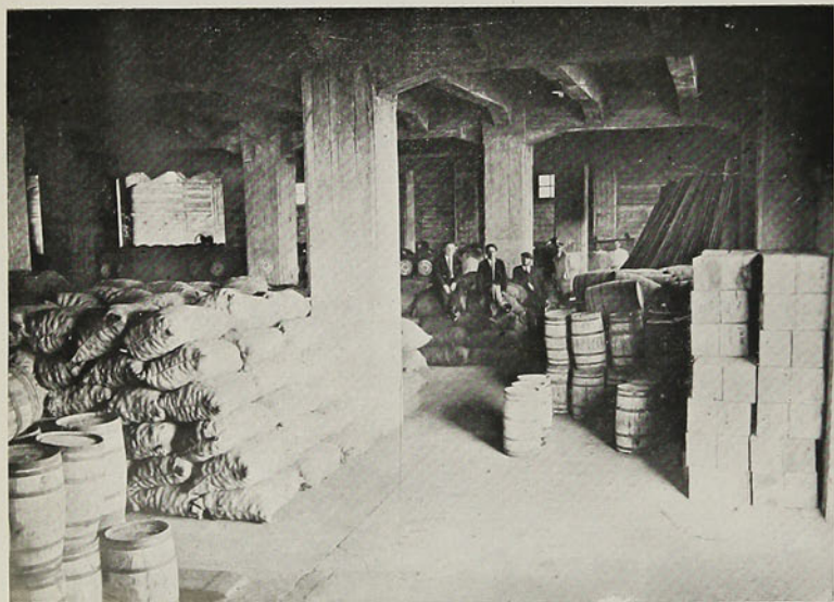
Interior de una de las bodegas de concreto armado que existen en la Sección Molo Sur.
