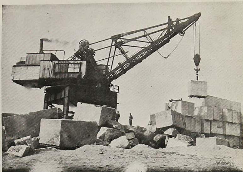
Grúa «Titán» en la faena de colocación de bloques en las nuevas obras de la prolongación del Molo
