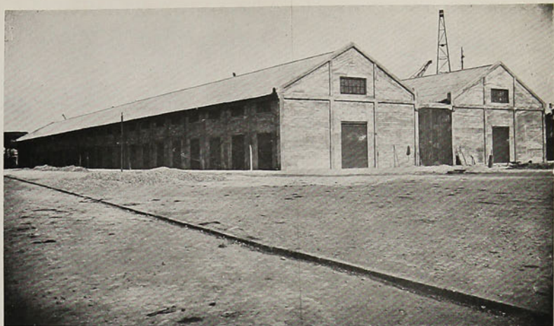
Moderna y confortable bodega de concreto armado, de dos naves y con línea férrea al centro, que se encuentra ubicada en el sitio de Espigones, contigua al nuevo Malecón de Tablestacas.
