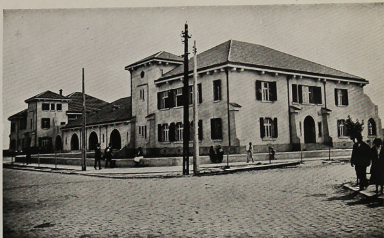
Edificio de la Gobernación Departamental, en el cual se encuentran ubicadas las diferentes oficinas Públicas.
