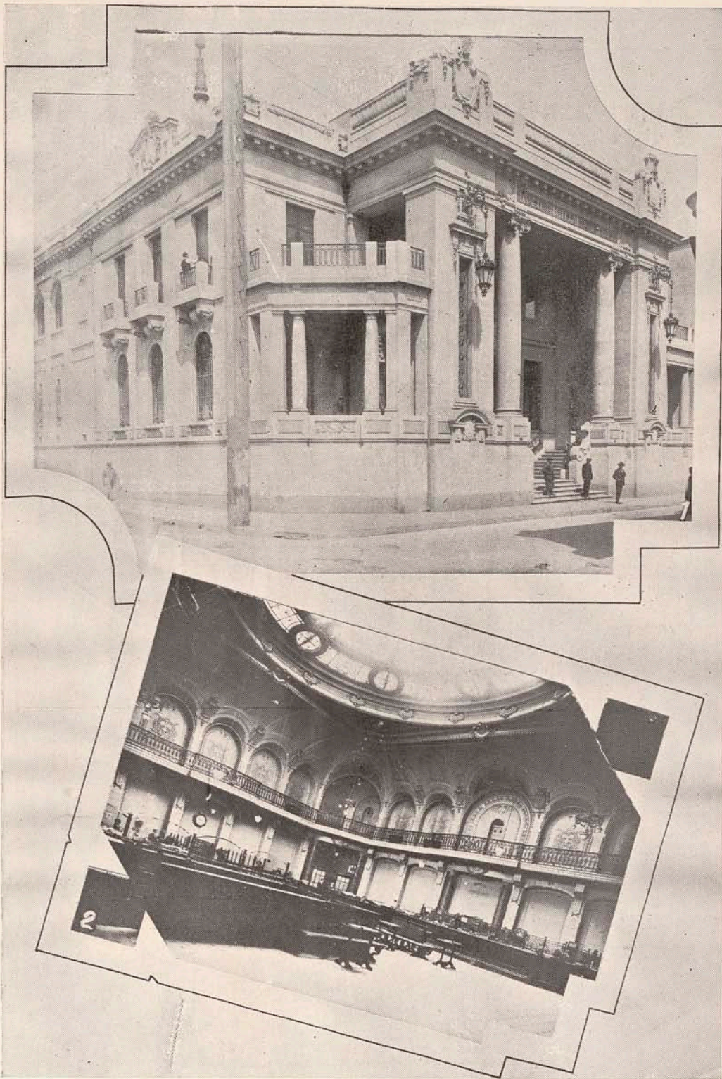
Banco Hipotecario de Chile .—1 Fachada.—2 Interior
