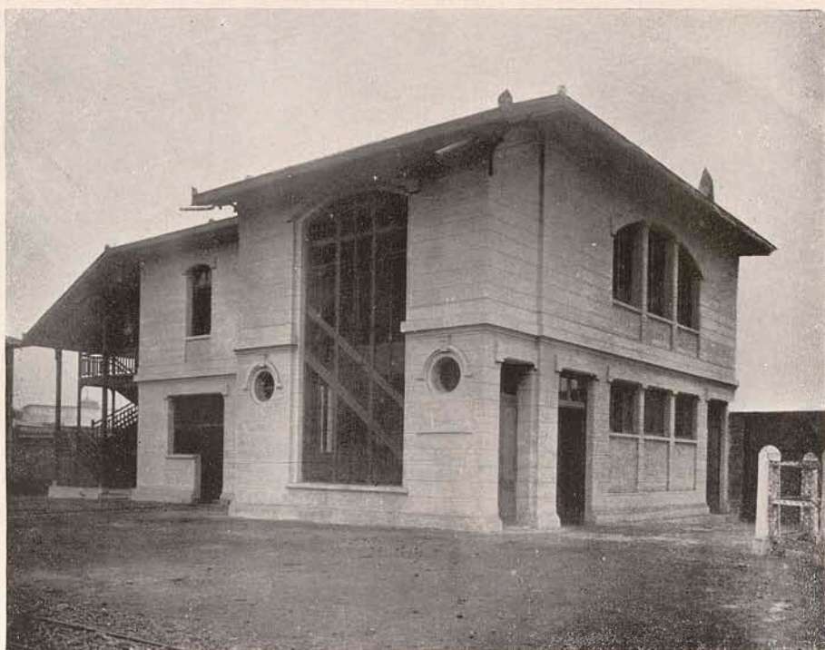
Hospital Arriarán.—Establo.—1 y 2 Lechería.
