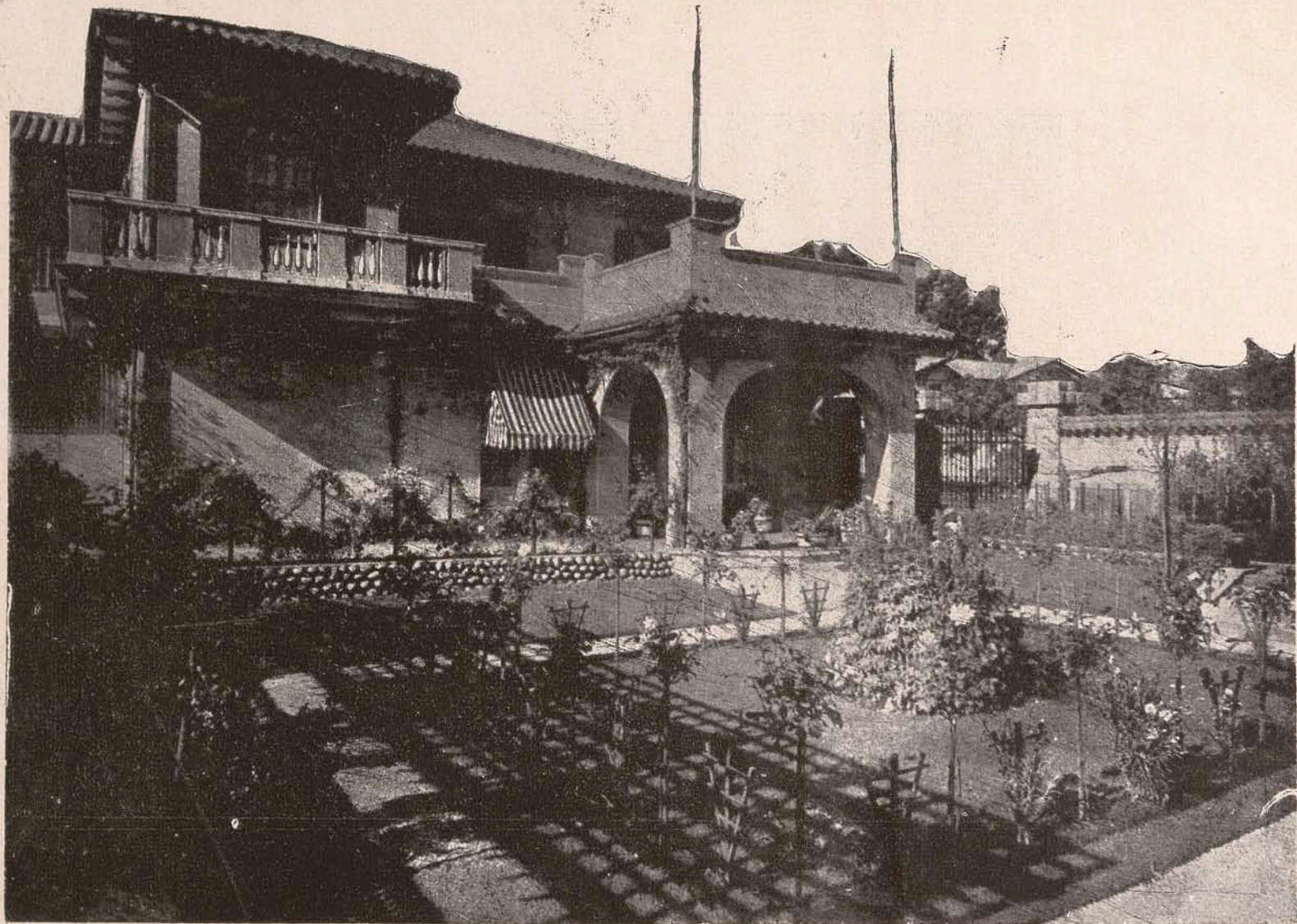
Perspectiva general.—Fachada principal
