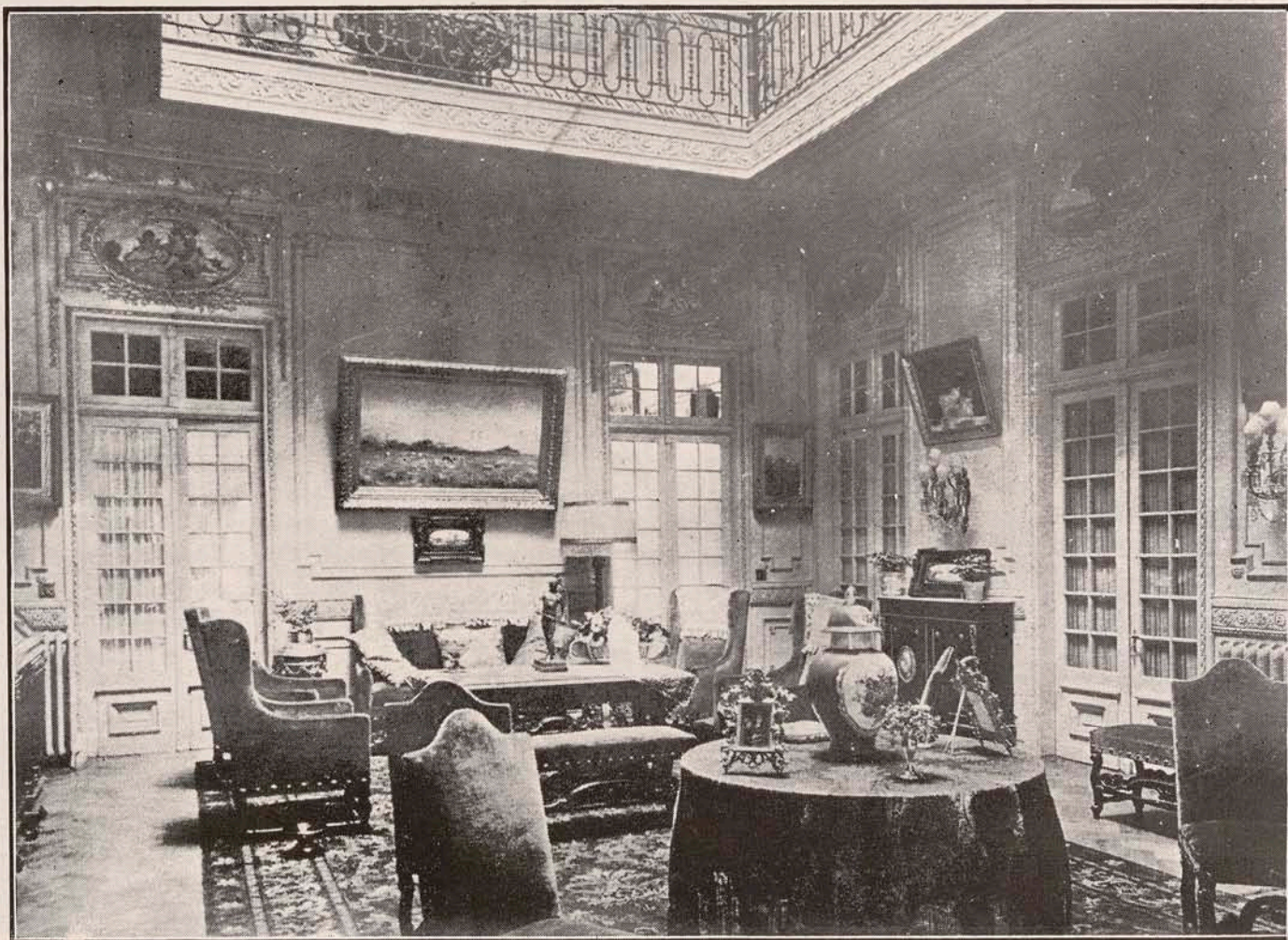
Hall de la casa de don Máximo del Campo.
