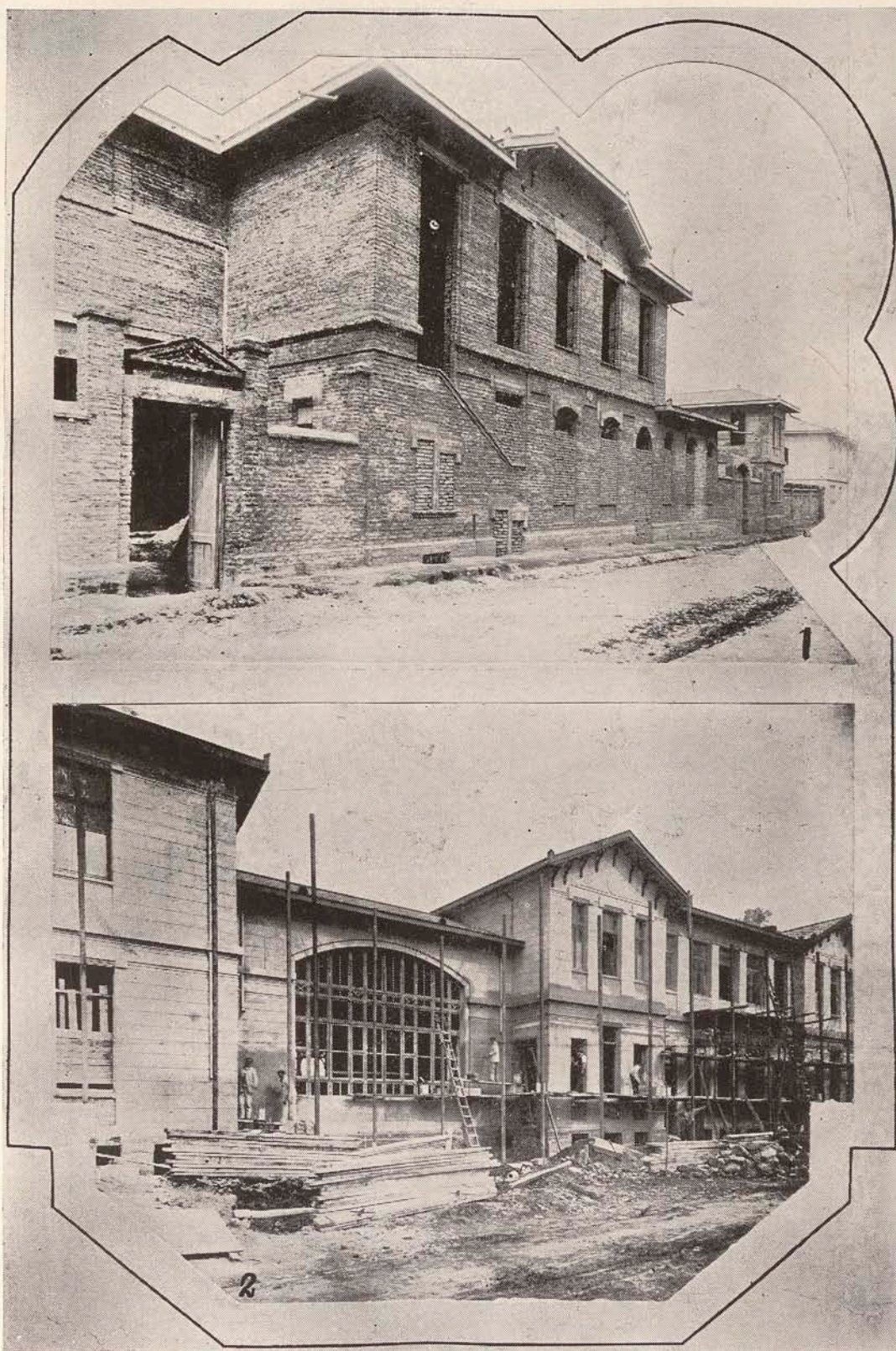
Hospital Arriarán. Pabellón en construcción en calle Santa Rosa
