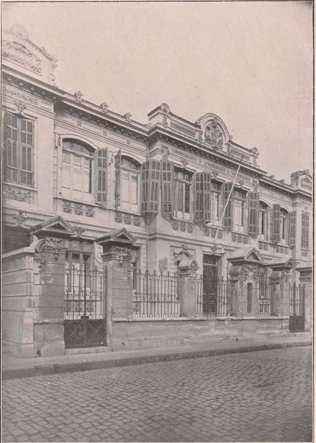
Edificio del Liceo de Niñas No. 2.—Calle Manuel Rodríguez
