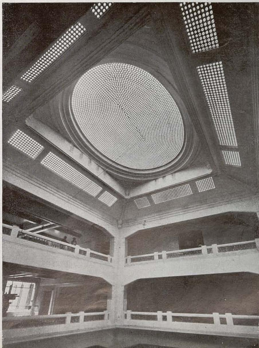
binaciones. Es, como muchos nuevos materiales, un hijo del concreto armado, y se le utiliza especialmente en cúpulas, tabiques translúcidos, pisos o veredas a través de los cuales se desea que filtre la luz para alumbrar los subterráneos y subsuelos.
