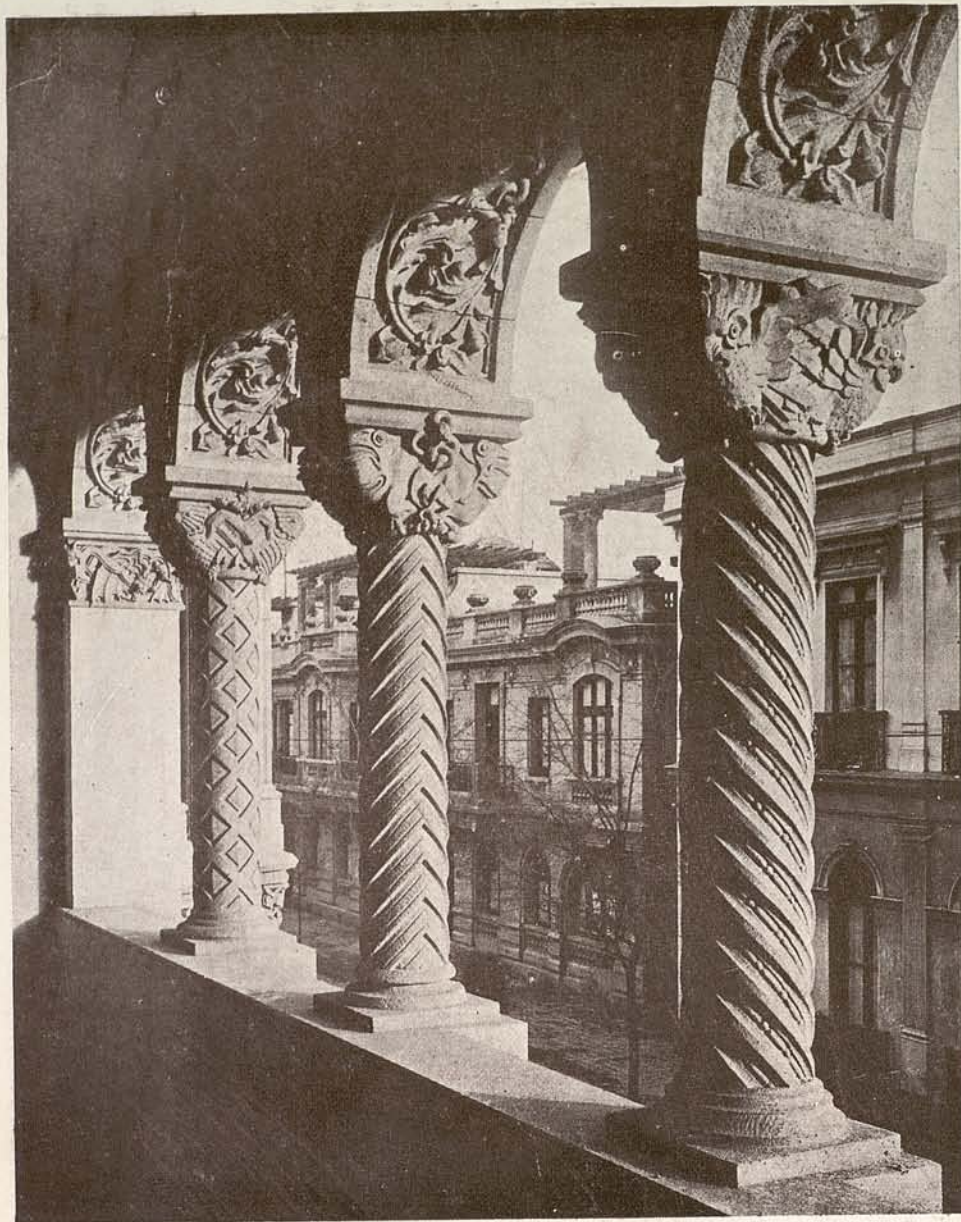
Detalle de la Loggia del 2.º Piso
