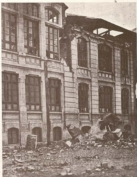
Escuela Juan Luis Sanfuentes. Vista de la Dirección Provincial de Educación. Edificio nuevo de ladrillos que no estuvo a la altura de las circunstancias. Sus escombros fueron lanzados por la conmoción sísmica al medio de la calle, alcanzando a veces la acera de enfrente.
