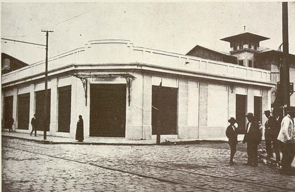
Casa Gath y Chaves - calle Comercio. Edificio de concreto que es un ejemplo elocuente de buena construcción. Apesar de su situación en esquina ha sido el que mejor resistió en todo Talca. Como dato curioso anotaremos que los seis grandes cristales de las ventanas quedaron absolutamente intactos.
