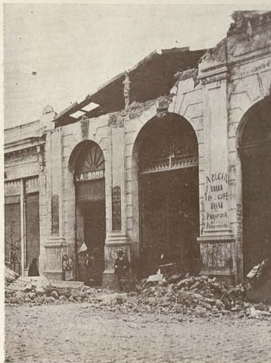
Entrada lateral al Mercado, calle 4 Oriente y 1 Norte. También el concreto tiene sus «peros» cuando no está bien calculado.
