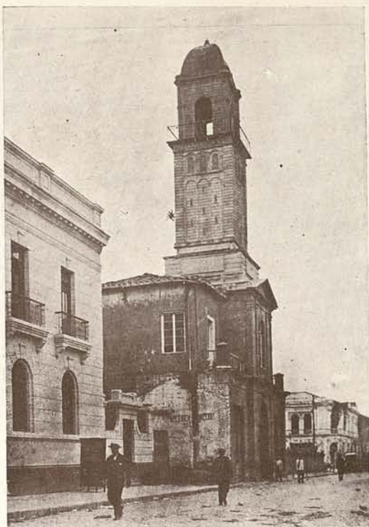
Cuartel de la 2. a Compañía de Bomberos, frente al Mercado. Ejemplo curioso de un edificio viejo de cerca de cincuenta años y que se mantuvo en pie con sus buenos ladrillos y su alta torre de madera.
