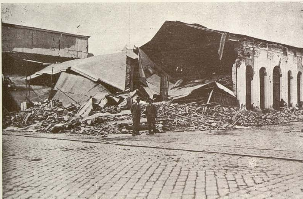
El drama de las esquinas. Tienda en calle Comercio esquina 6 Oriente. Vistas como estas hay muchas en Talca. Las construcciones en esquinas debieran ser especialmente asísmica pues durante el seísmo constituyen los verdaderos pilares de sostenimiento de la manzana.
