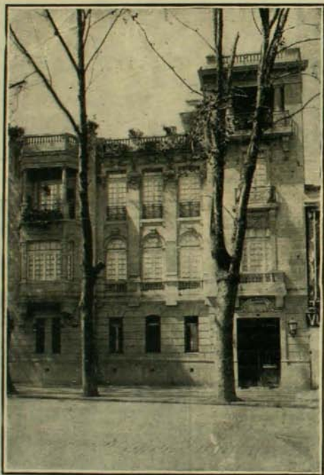
Casa de don Ramón Balmaceda, construida por don Julio Bertrand Vidal
