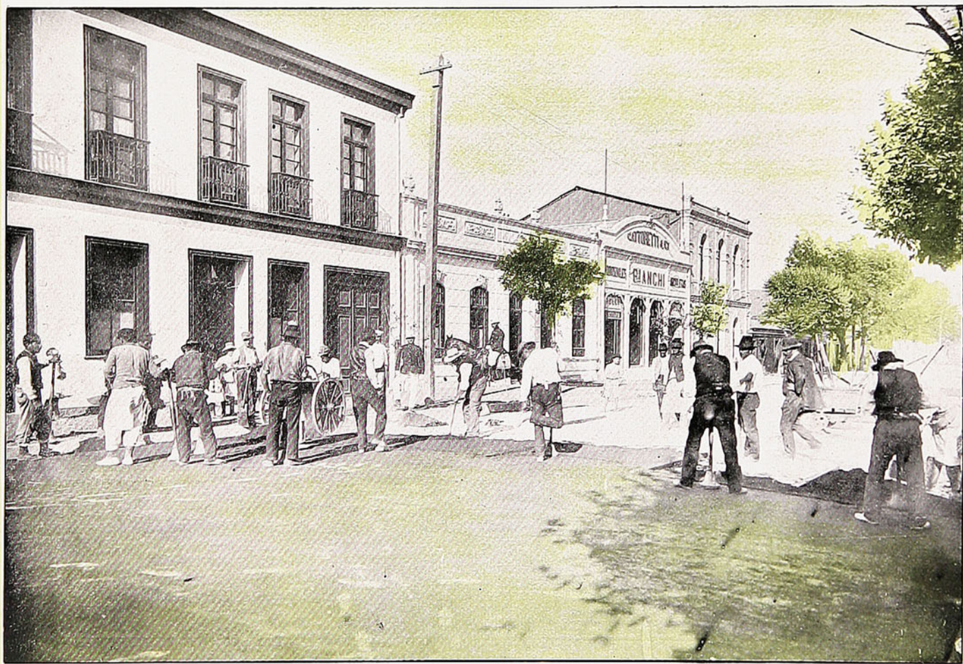
OTRO ASPECTO DE LOS TRABAJOS EJECUTADOS POR LA EMPRESA FRANCISCO GARNHAM Y CIA., CON ASFALTO NATURAL DE ROCA DE SAN VALENTINO.
