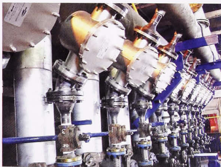
Doce catalizadores Vostecs de 2 MM Kcal c/u instalados en la zona de empape del horno de palanquillas en Huachipato
