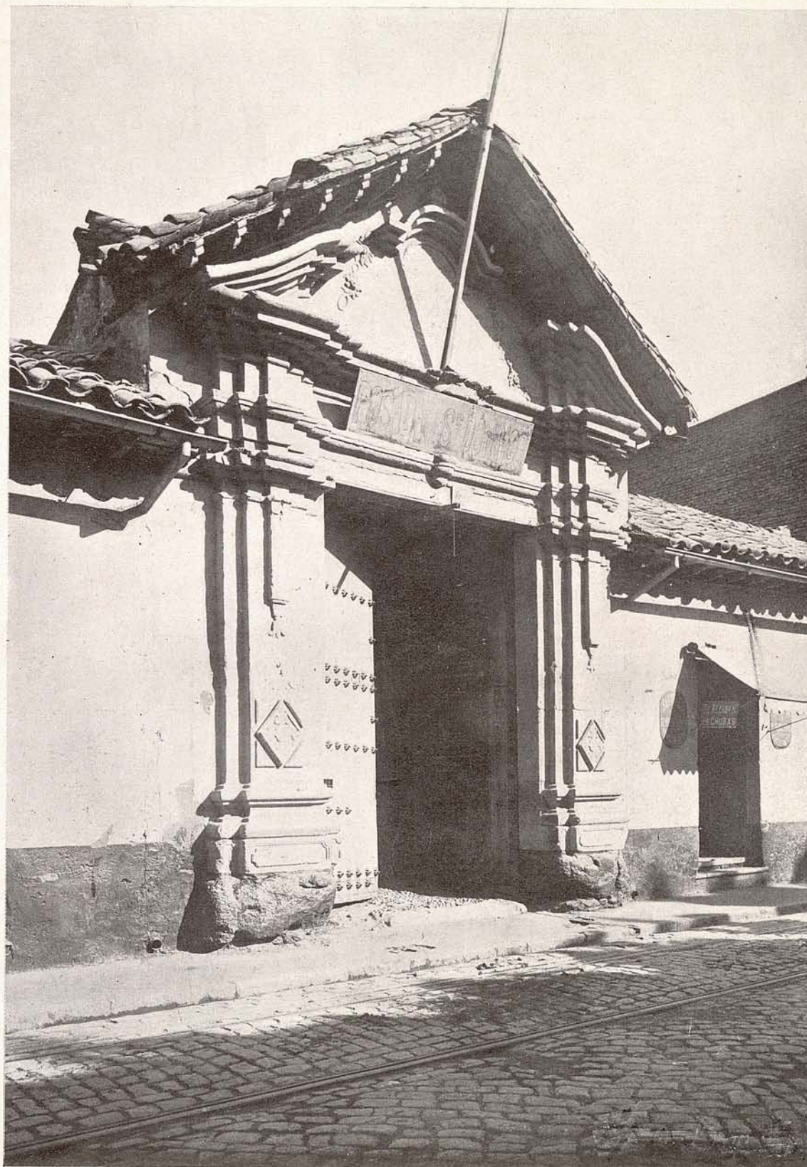
Casa Colonial, Calle Sto. Domingo
