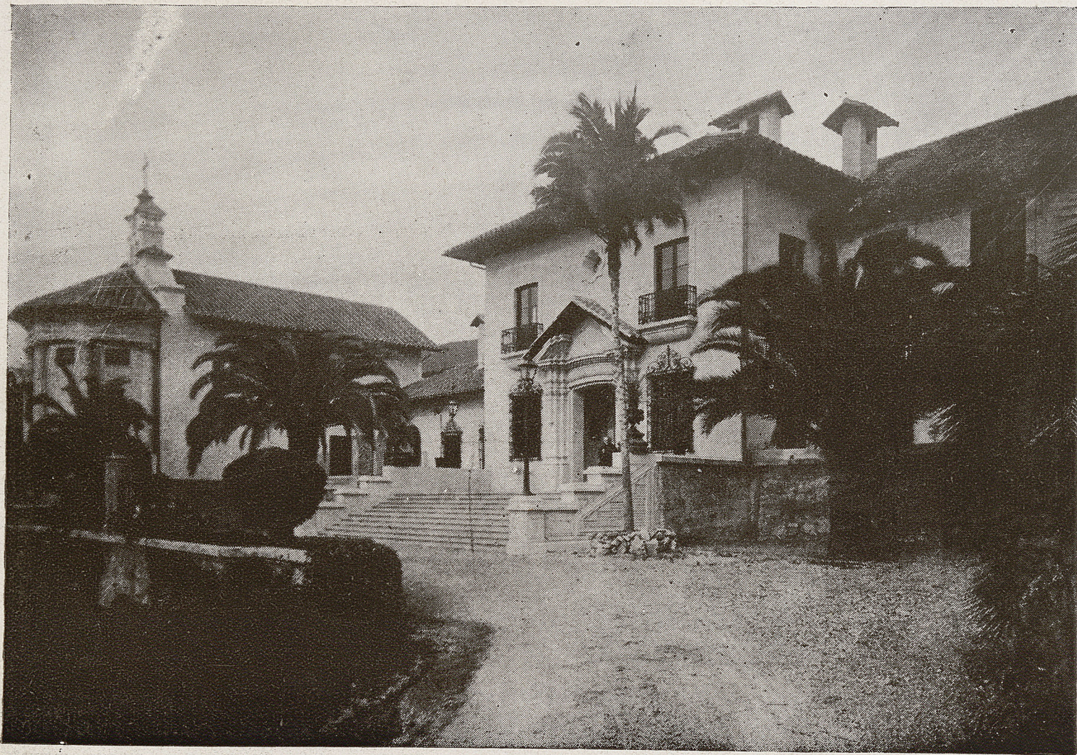
Las Casas de la Hacienda San Isidro, Quillota.—Propiedad de la Sra. María Luisa Mac-Clure de Edwards.—Fachada principal.—La Capilla a la izquierda.—Arquitecto: Sr. Josué Smith Solar
