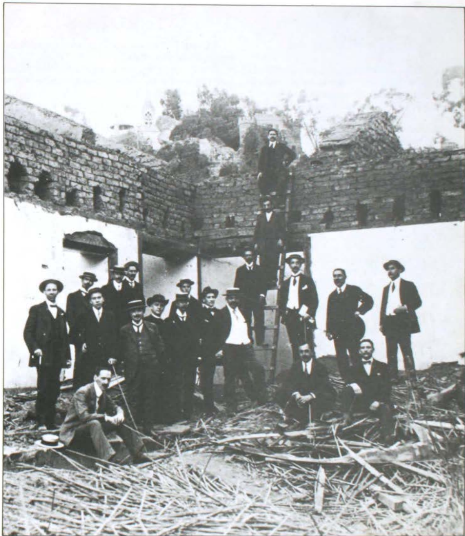
Fotografía de la demolición del convento e iglesia de las monjas Claras (1912), ubicado en el lugar que ocupa actualmente la Biblioteca Nacional, en Alameda Libertador Bernardo O'Higgins, entre Moneda, Mac-Iver y Miraflores.
