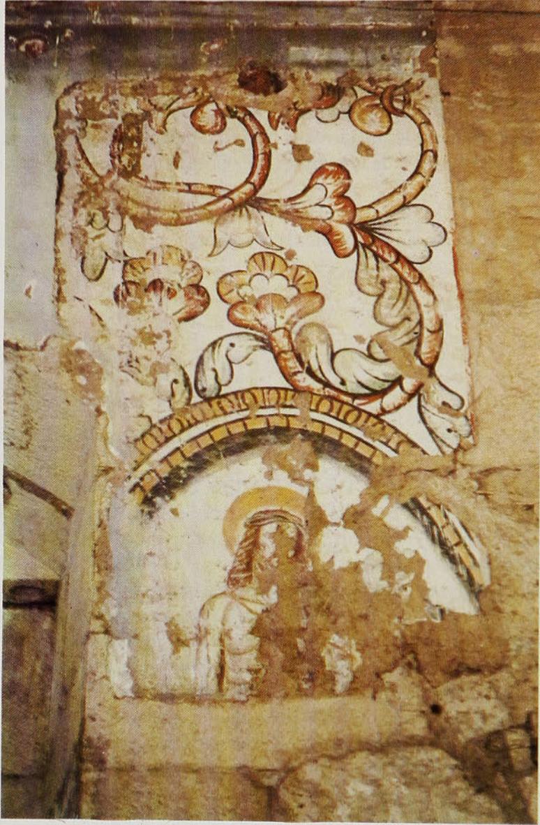
Convento de San Francisco. Posible mezcla a base de argamasa, huevo y penca de tuna. Santiago, Chile, siglo XVII.
