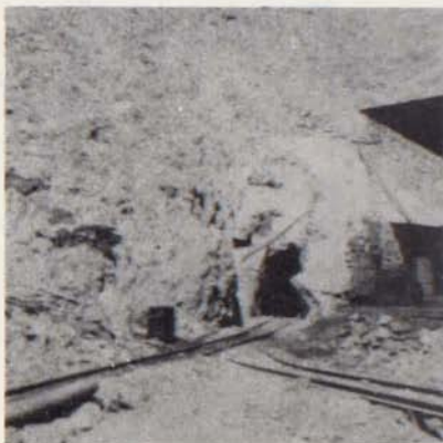
BOCAMINA / "LA RECOBRADA" - COPIAPO
