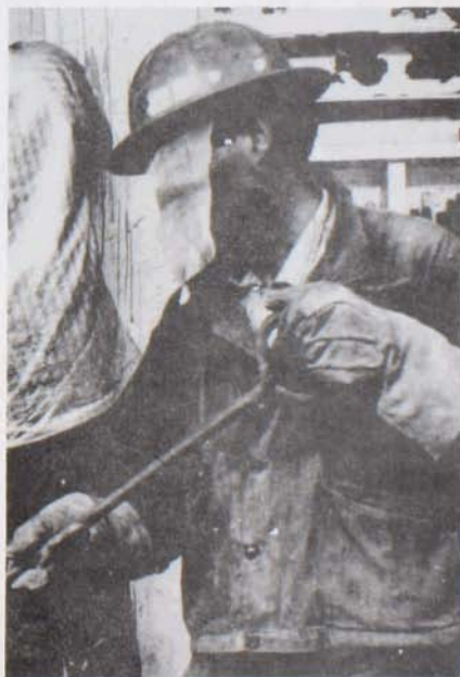
OPERARIO EN LA FUNDICION
