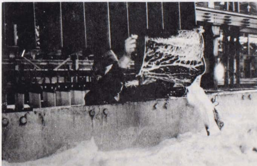
OPERARIO AGREGA REACTIVO A LOS ESTANQUES DE REFINO ELECTROLITICO POTRERILLOS
