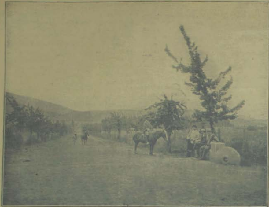
Vista de un camino tomada desde las casas
