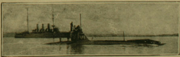
Submarino inglés "A-14", del año 1898. Estos buques son del tipo "submarino puro" y sólo sirven para operar en puertos y bahías.
