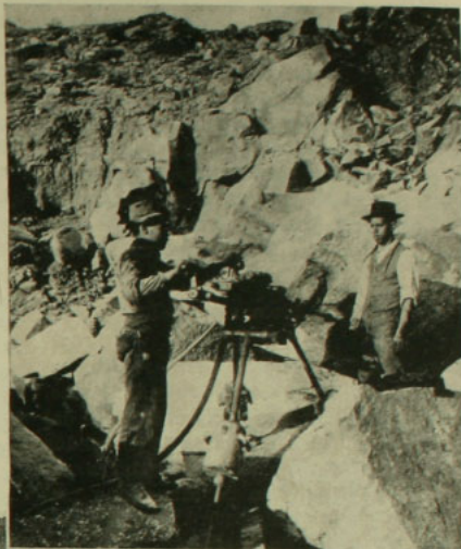
En las canteras.— Perforadora que funciona por medio del aire comprimido
