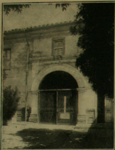
Patio de una antigua casa de Santiago
