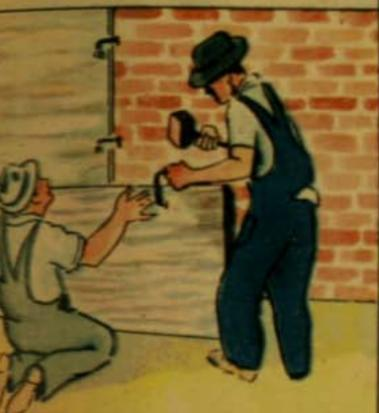
4. Algunos edificios se revisten en su exterior con planchas de mármol. Aquí se ven unos obreros entregados al trabajo de colocar planchas de mármol en una fachada.
