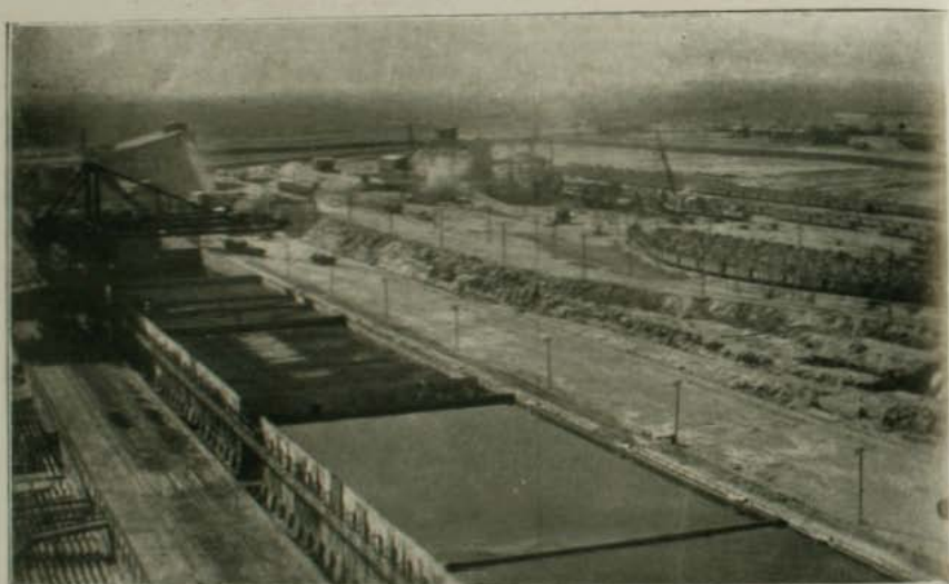
Estanques de lixiviación llenos de caliche y solución.
