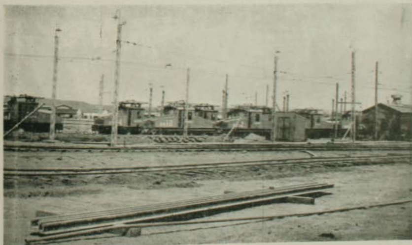
Estación de Máquinas eléctricas.
