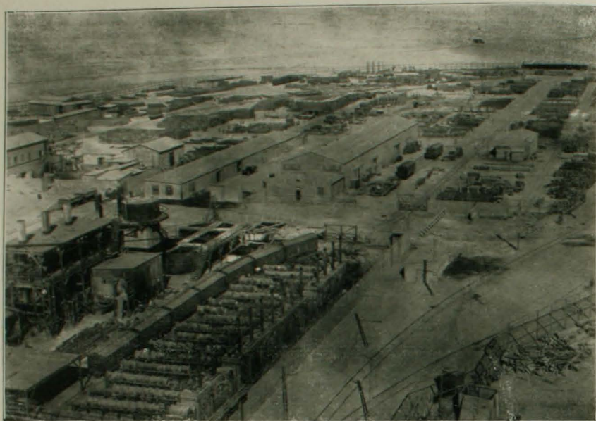
Planta de Yodo y Bodegas de Materiales.
