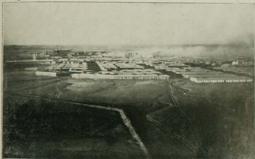
Vista general de la Planta y Campamento.
