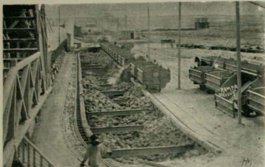
Caliche de la pampa vaciándose de los carros a la rampa de las ascensoras.
