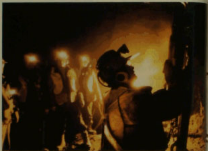
Trabajos con perforadora hidráulica en la mina subterránea de División Andina.
