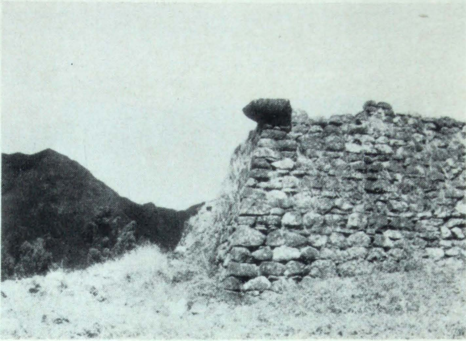
Foto 5. Detalle de la esquina nord-occidental del fuerte mostrando la piedra fundamento de la garita.
