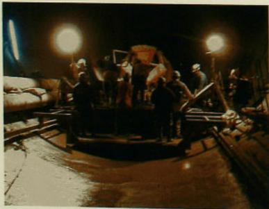
89 **LA ZONA DE CAÍDA** está compuesta por un pique vertical de 100 metros y 9,2 m de diámetro, que se bifurca dando origen a dos túneles blindados para alimentar las unidades generadoras. La presión ejercida por la columna de agua, que cae en este punto verticalmente producto del desnivel entre la bocatoma de aducción y la caverna de máquinas, permite accionar ambas turbinas.
