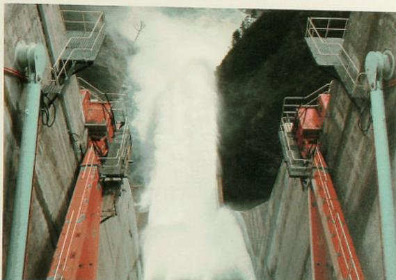
60/61 **EL VERTEDERO CONSTA DE TRES VANOS**, controlados con sendas compuertas de vector, que regulan el paso del agua hacia el rápido de descarga, cuyo tramo final o salto de esquí arroja el agua lejos de la base de la presa.
