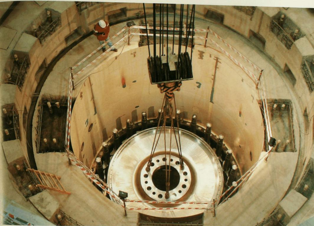
106/107 **CON UN PESO DE 176 TONELADAS**, el rodete está tan precisamente balanceado que puede girar con la fuerza de una mano. Sin embargo, está diseñado para convertir la tremenda potencia hidráulica que lo alimenta en la energía mecánica necesaria para, conectado a través de un eje, hacer girar un generador de 545 toneladas de peso.
