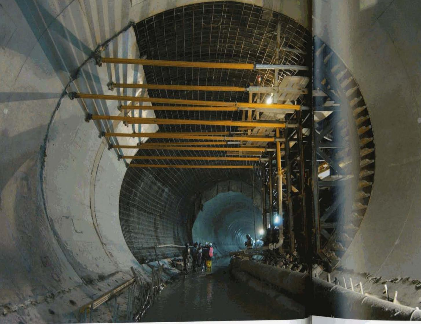
86/87 La cantidad de hormigón colocado en las paredes del túnel, con un espesor de 30 cm, alcanzó a 65.000 m<sup>3</sup>.
