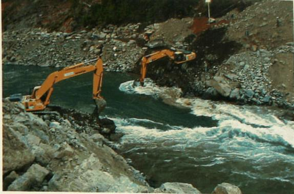
16 **FEBRERO DE 1999**, se inicia en un cajón estrecho y profundo del río Biobío la construcción de la presa con los trabajos de excavación de las fundaciones sobre el nivel del río.
