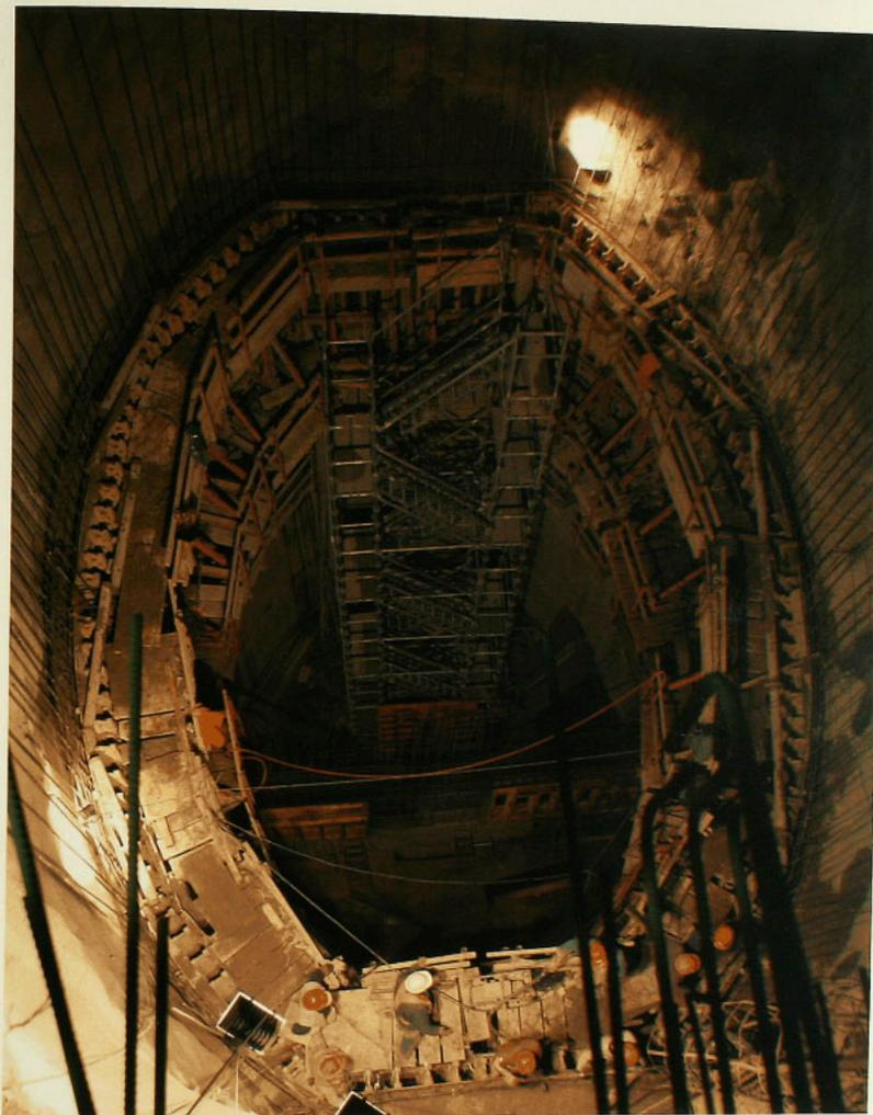
83 **PIQUE DE COMPUERTAS DE LA BOCATOMA**, el primer control del flujo de las aguas en su tránsito por el interior del túnel de aducción.
