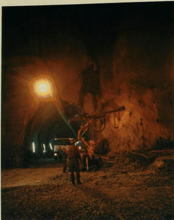
92/93 ABRIR EL ESPACIO SUBTERRÁNEO para albergar la casa de máquinas implicó extraer, mediante camiones, 137.280 m<sup>3</sup> de roca. Para ingresar a ella, se transita por un túnel de 280 m de longitud, diseñado para permitir el acceso de los grandes equipos en su etapa de montaje.
