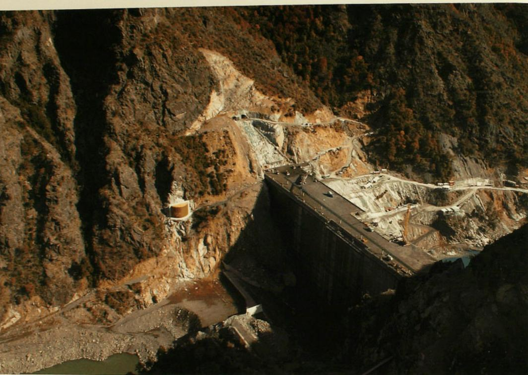
44/45 **LA PRESA RALCO** tiene una altura máxima de 155 metros y una longitud de 360 metros en su coronamiento.
