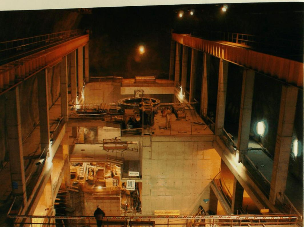
100/101 AL INTERIOR DE LA CAVERNA se construyó el edificio donde se alojan los distintos equipos de generación de la central. Los hormigones se colocaron en varias fases, en paralelo con la instalación de partes de las máquinas.
