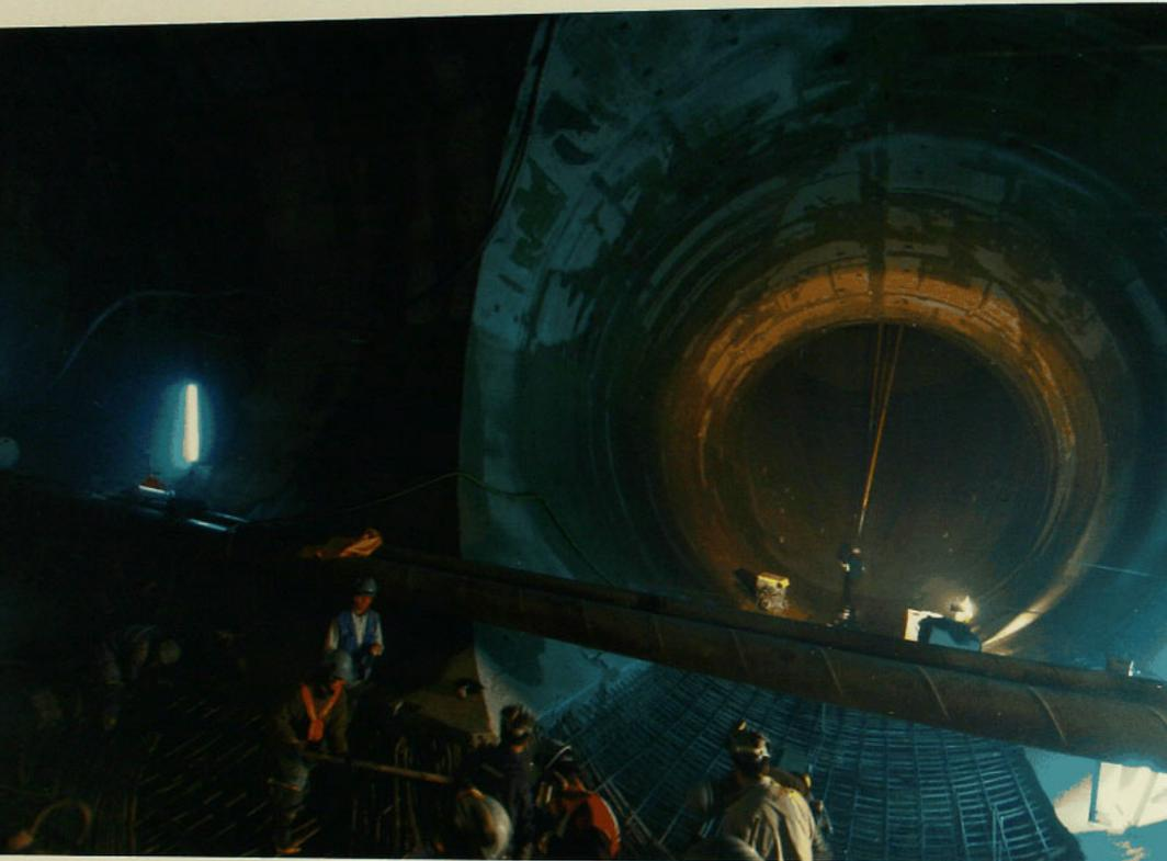
88 **UN MOLDAJE DESLIZANTE** remata la faena de hormigonado avanzando sobre la enfierradura de la contrabóveda.
