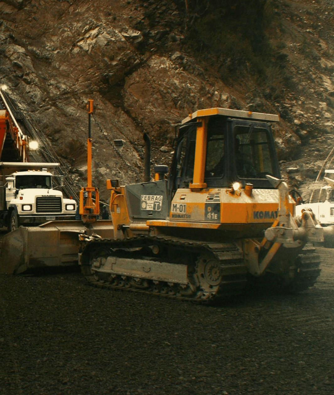
28/29 **PODEROSAS MÁQUINAS** esparcían el HCR, estaban monitoreadas por un sistema láser, asegurando de esta forma el correcto espesor de cada una de las aproximadamente 450 capas de hormigón necesarias para coronar la presa, hecho que ocurrió en octubre de 2003.
