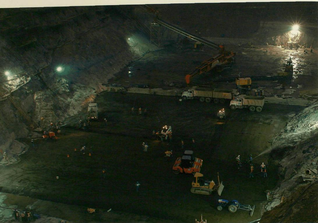
**22 LA COLOCACIÓN DEL HORMIGÓN COMPACTADO CON RODILLO (HCR)**, comenzó en enero del 2002. Sin detención, salvo 40 días de condiciones climáticas extremas, 654 días fueron necesarios para llegar a los 1.5 millones de m<sup>3</sup> totales, el equivalente a una carretera de dos pistas de unos 1.000 kilómetros.
