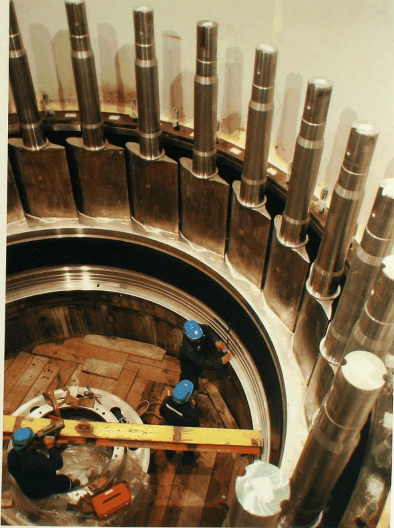
104 **CUATRO NIVELES DEBEN DESCENDER** los equipos que componen el acoplamiento entre el túnel blindado y el caracol, compuesto por los tubos de unión y la válvula de mariposa.
