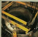
**OCTUBRE** Se realiza el montaje del primer equipo de la caverna de máquinas (uno de los dos estatores) en el foso de la Unidad N° 1.
