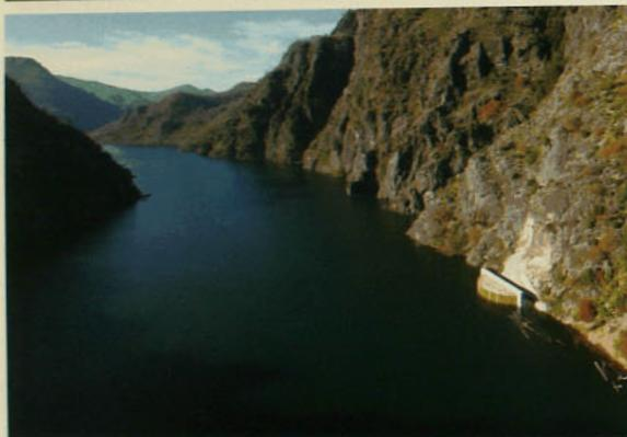
54 EJEMPLO ELOCUENTE de la formación del embalse fue el paulatino cubrimiento de la bocatoma, que se encuentra en la ribera sur, por donde ingresan las aguas al túnel de aducción para ser conducidas a la casa de máquinas.
