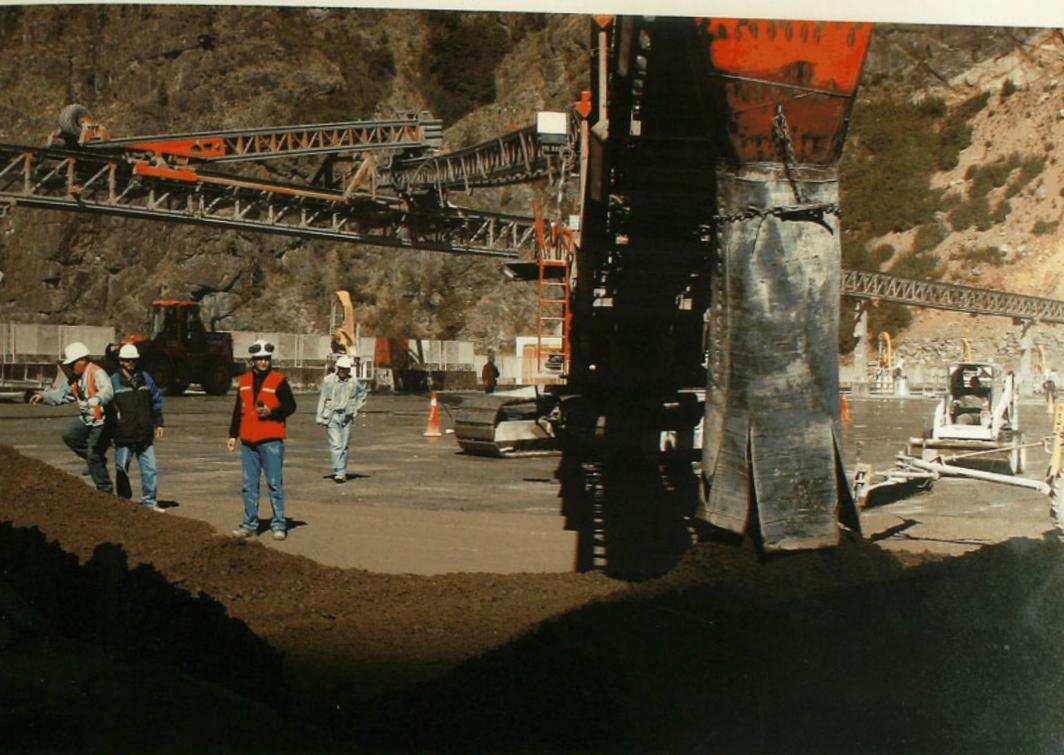
40/41 **LA APLICACIÓN DE HCR** requirió de una acuciosa supervisión por parte de los ingenieros inspectores de obra destacados por Ingendesa. Espesor, humedad, temperatura, compactación y mil detalles más se chequearon una y otra vez, la historia de muestras y controles es amplia y detallada.
