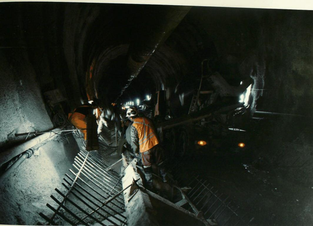
76 **LA CANTIDAD TOTAL DE TIERRA Y ROCA** que se removió y extrajo desde las profundidades para abrir el rajo del túnel de aducción fue de 570.000 m<sup>3</sup>. Para la excavación del túnel se usó la técnica tradicional de perforación y disparo, con extracción de la marina en camiones.
