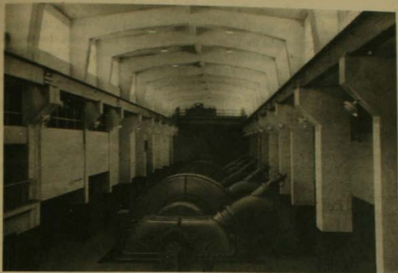
Sala de Máquinas de la Central Cipreses.
