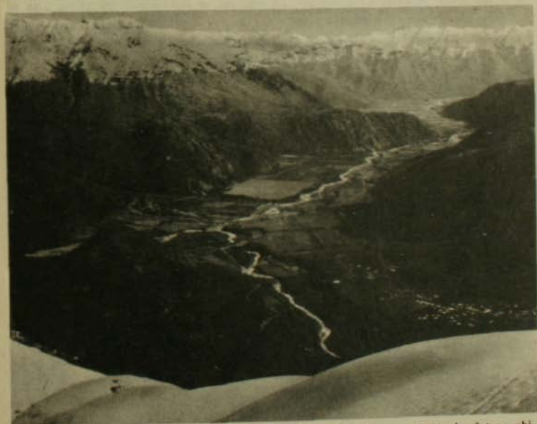
Vista panorámica del valle del río Cipreses y su desembocadura en el Maule, futura ubicación de la Central Isla. A la derecha, población de empleados.
