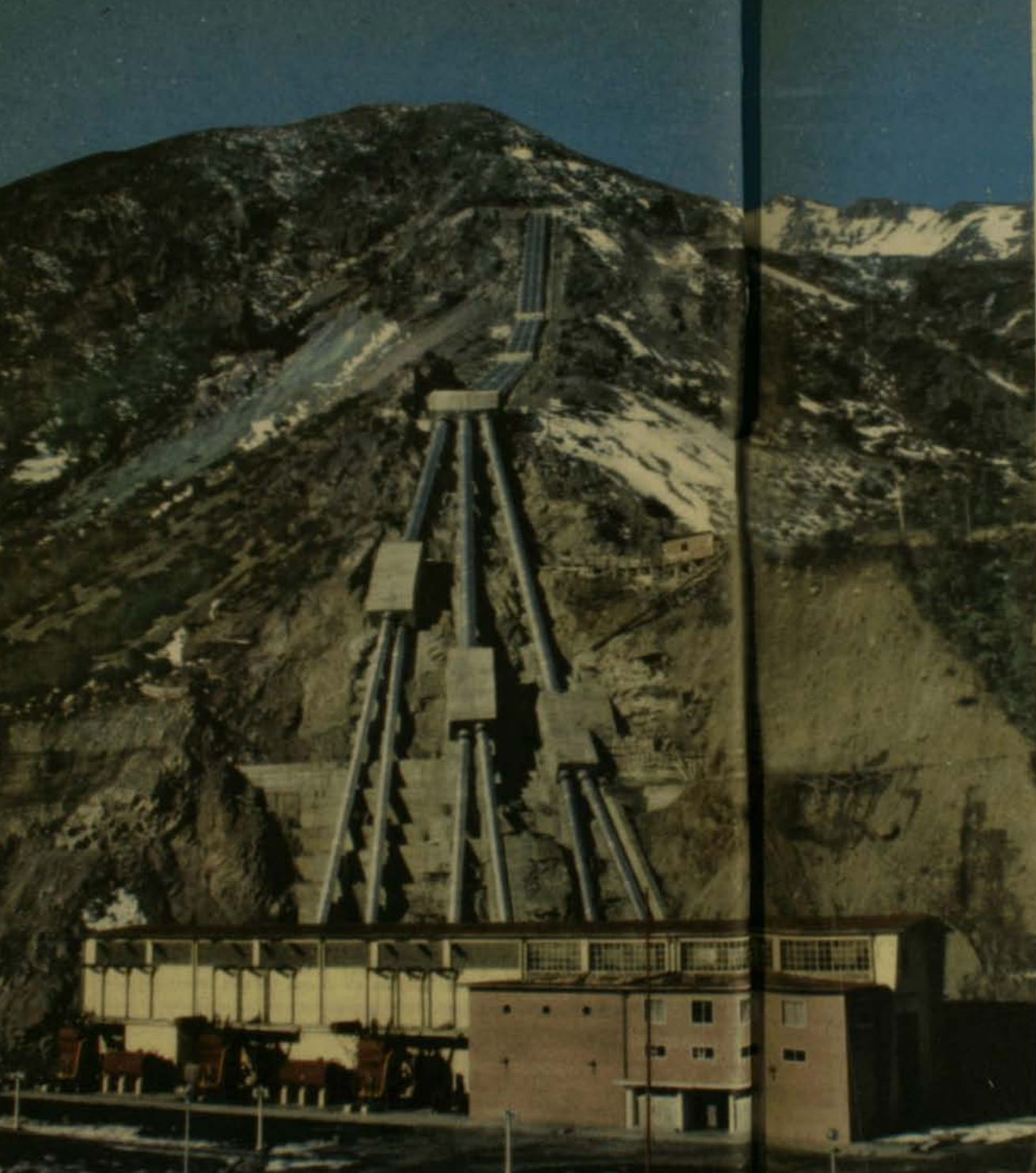
Vista, desde el lado de aguas abajo, de la Casa de Máquinas, mostrando los transformadores de subida y cuerpo de edificio correspondiente a la Sala de Comando y oficinas.
