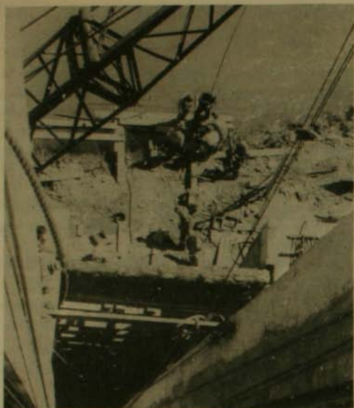
Faena de construcción de uno de los piques de bocatoma.
