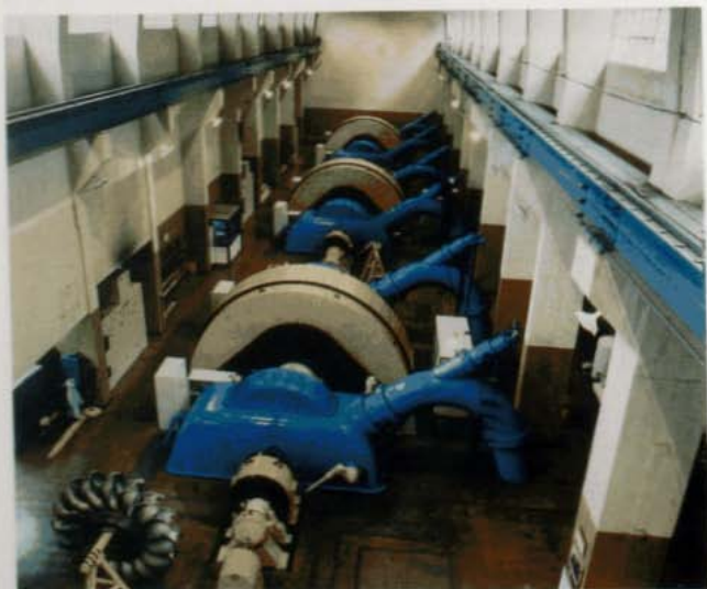
Las tres unidades generadoras de Cipreses entregan 101 MW al Sistema Interconectado Central.
