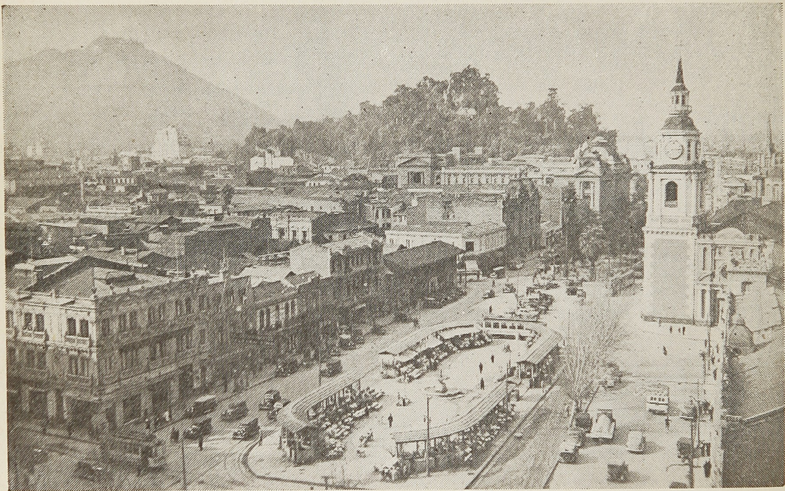
Vista parcial e Iglesia San Francisco.
