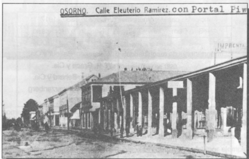
Portal Piwonka, Centro Comercial de Osorno.
