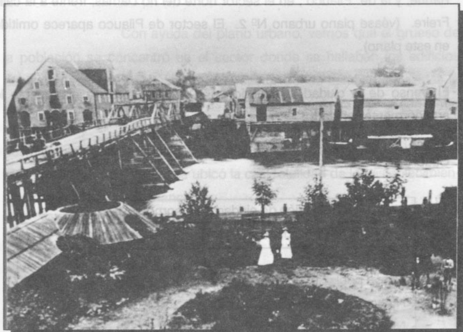
Antiguo Puente "San Pedro", construido sobre el río Rahue con el fin de unir los sectores de Rahue y Osorno.
