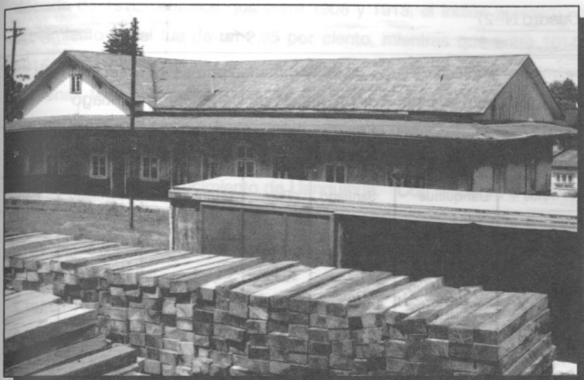
Estación de ferrocarriles de Río Negro.
