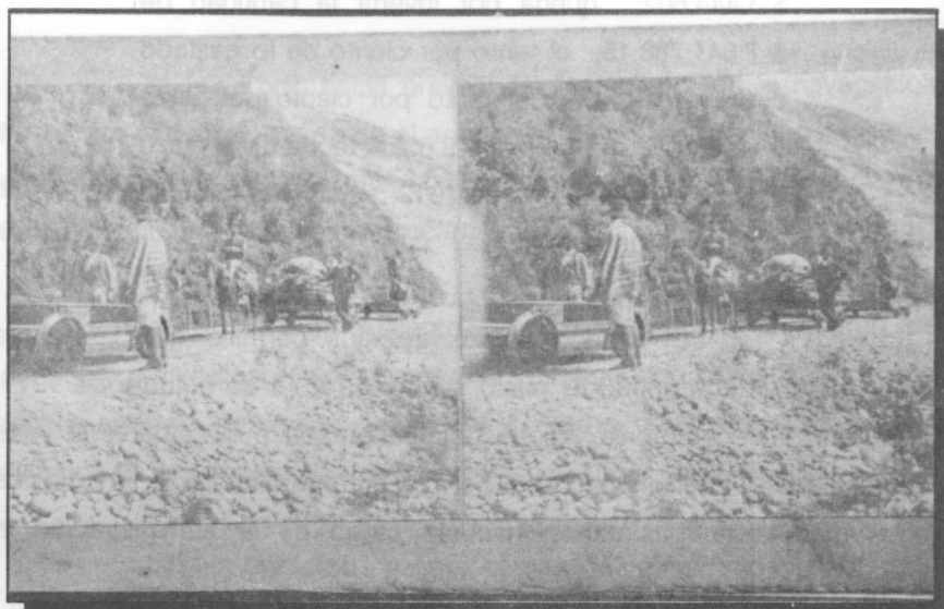
Tendido línea férrea entre Osorno y La Unión, a fines del s. XIX (foto: Museo de Osorno)
