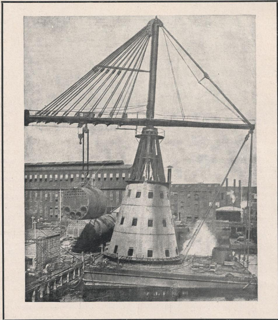
Grúa flotante, transportando una caldera de grandes dimensiones, del muelle al vapor en construcción
