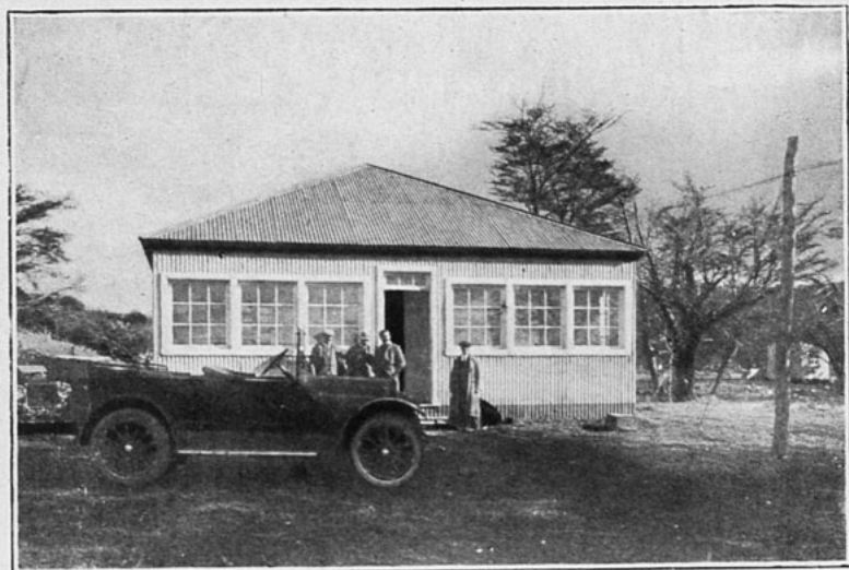
CERRO CASTILLO.—(Sección Johnson).—Casa del capataz.
