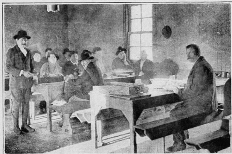
CAMERON (Tierra del Fuego).—Comedor para trabajadores.
