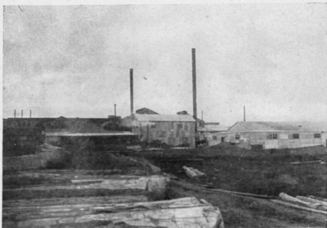
SOCIEDAD FRIGORIFICA DE PUNTA ARENAS.—Grasería
