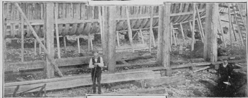
Babor de «Sara». Buque en construcción de cerca de 1,000 toneladas y ya entregado al servicio regional
