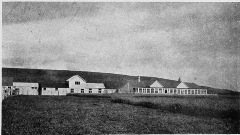
ESTANCIA «LAS LAGUNITAS».—Casa Administración.
