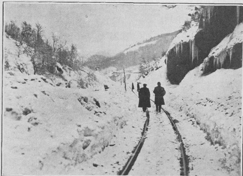
Entrada a la mina 'Loreto' de la firma 'Menéndez Beheby.'
