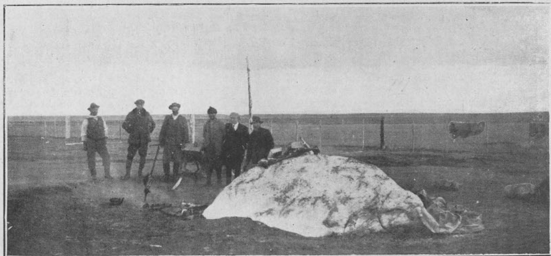
Alojamiento de ovejeros en la Patagonia, nótese el clásico asado al palo
