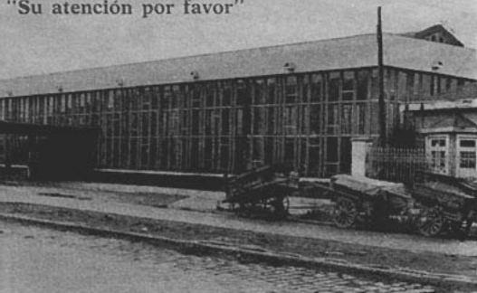
Fachada de la Estación de Temuco. El amplio hall encierra zonas de espera, boleterías, buffet, servicios higiénicos, kioskos y Correos y Telégrafos
