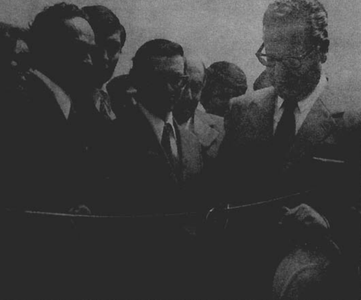
Foto Superior: El Presidente Salvador Allende procede a inaugurar la Subestación Eléctrica de Concepción. A su lado el Director de FF. CC. Ing. Alfredo Rojas Castañeda
