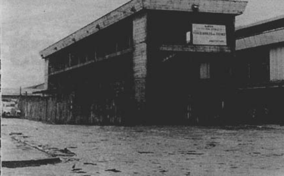
Bloques sin concluir que incluyen las Secciones de Materiales, Servicio Social, Vía y Obras, Ayudantía Estación, etc.
