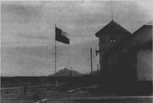
Vivirí, a 4.068 mts. de altura es la última estación en territorio chileno, del F. C. de Arica a La Paz. En la soledad del Altiplano se destaca el puesto de Carabineros a cuyo frente flama el tricolor nacional (Foto del autor)
