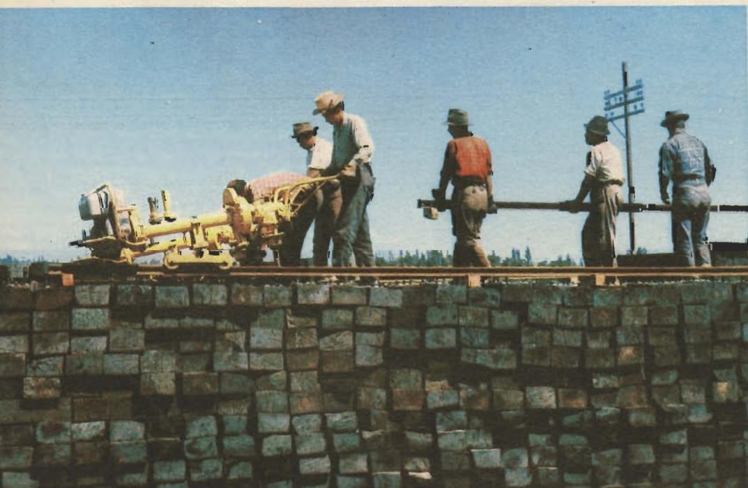
*Además de electrificar su red, los Ferrocarriles del Estado acometen actualmente la renovación progresiva de sus rieles tradicionales, reemplazándolos por el moderno sistema de enrieldadura soldada, que asegura en la práctica una vía "continua" y permite a los trenes una carrera más rápida, suave y silenciosa. El grabado muestra una etapa de la preparación de los durmientes especiales sobre los que van los nuevos rieles, de 120 metros de largo cada uno*
