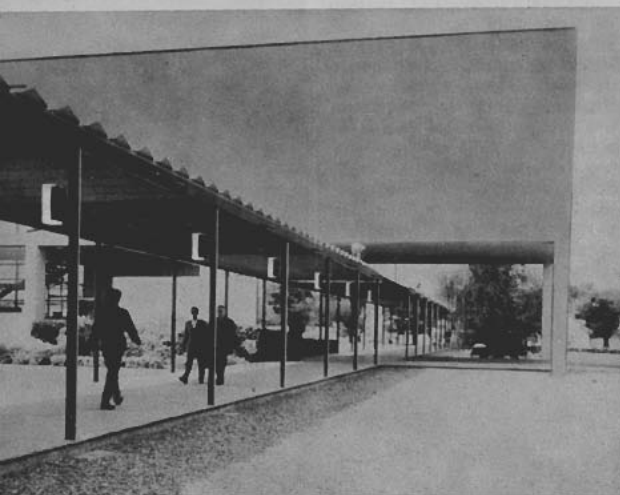
Entrada principal y comunicación con los pabellones
