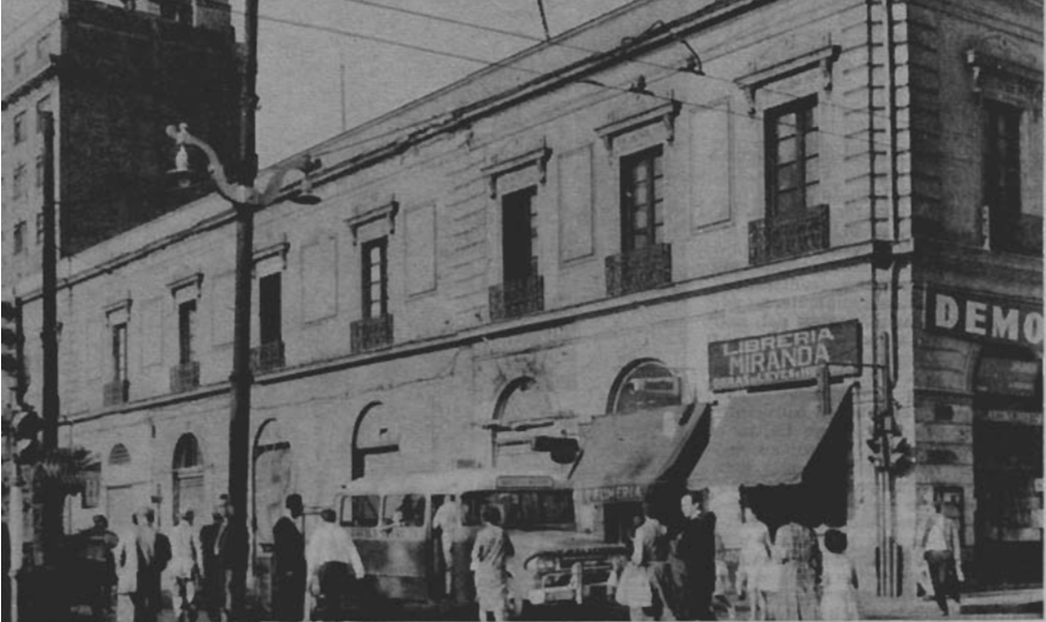
Calle Bandera esquina de Compañía, edificio recién demolido
