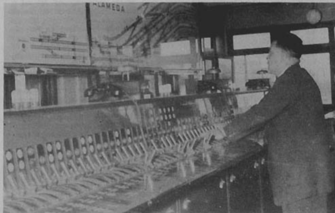
Cabina de la Estación Alameda, dotada de los últimos adelantos en el sistema de señalización; nótese su complicado mecanismo
